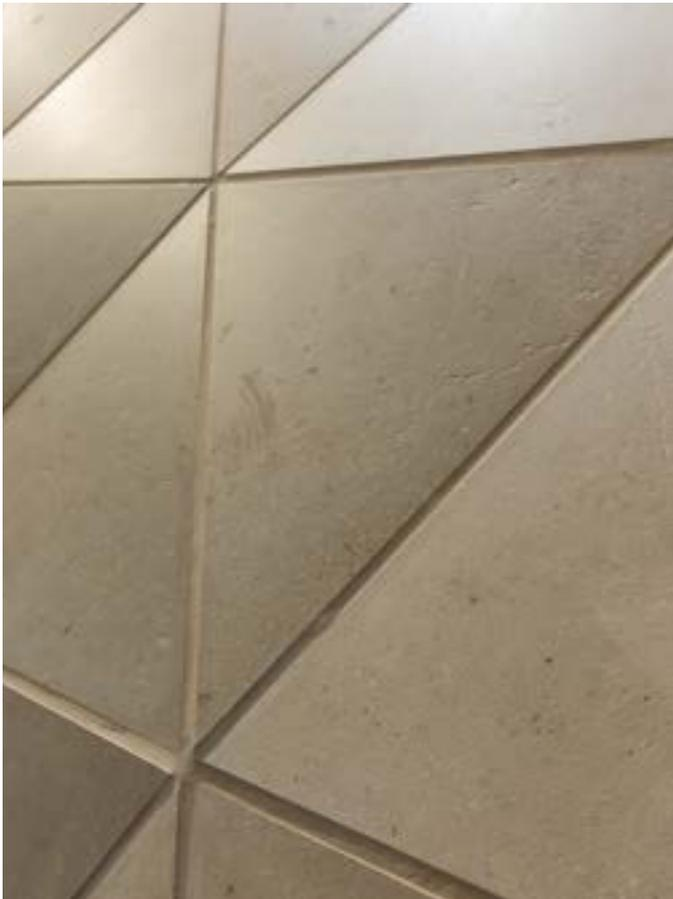
Detail der Natursteinfliesen als optimal zugeschnittene Bekleidung der Freiform, getönter Fugenmörtel als zusätzliches Gestaltungsmittel
