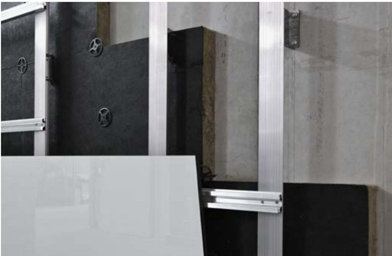
StoVentec Systemaufbau mit Edelstahl-Aluminium-Unterkonstruktion
