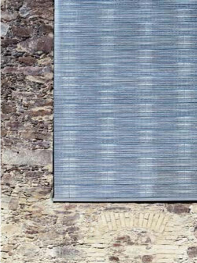
Per Siebdruck mit Fotos gestapelter Glastafeln rückseitig bedruckte Glaselemente
