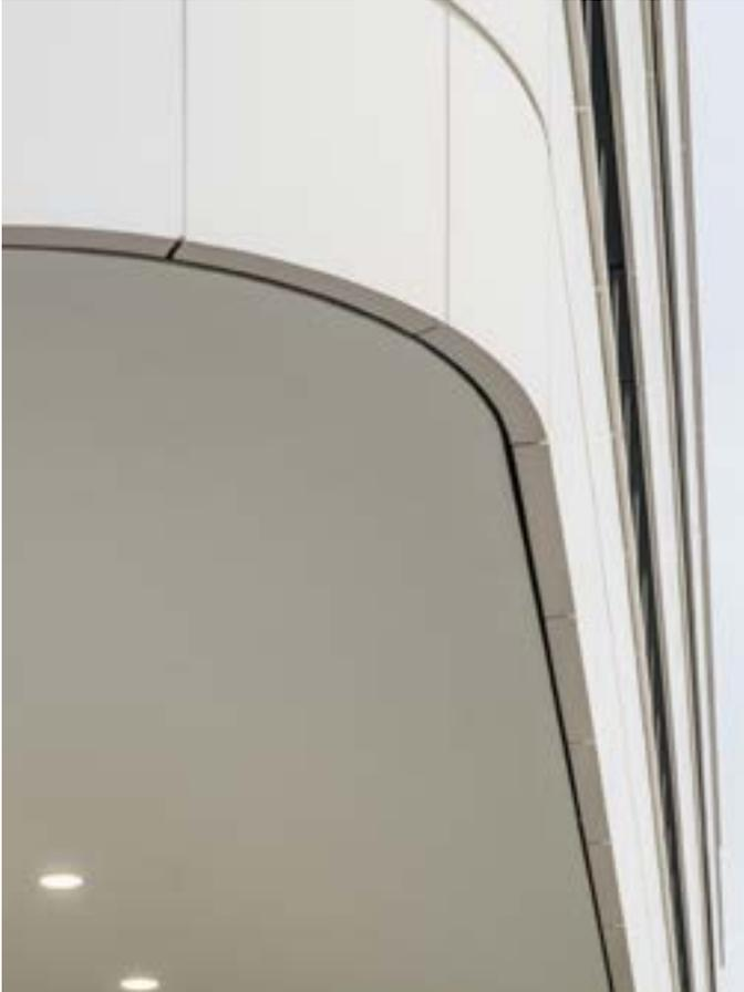
Detail am Übergang der PMMA-Fassadenelemente zur Deckenbekleidung
