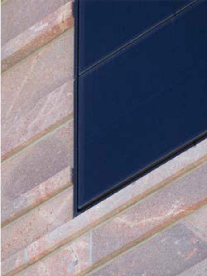
Detail am Übergang der nicht sichtbar befestigten Photovoltaik-Paneele zur Natursteinfassade
