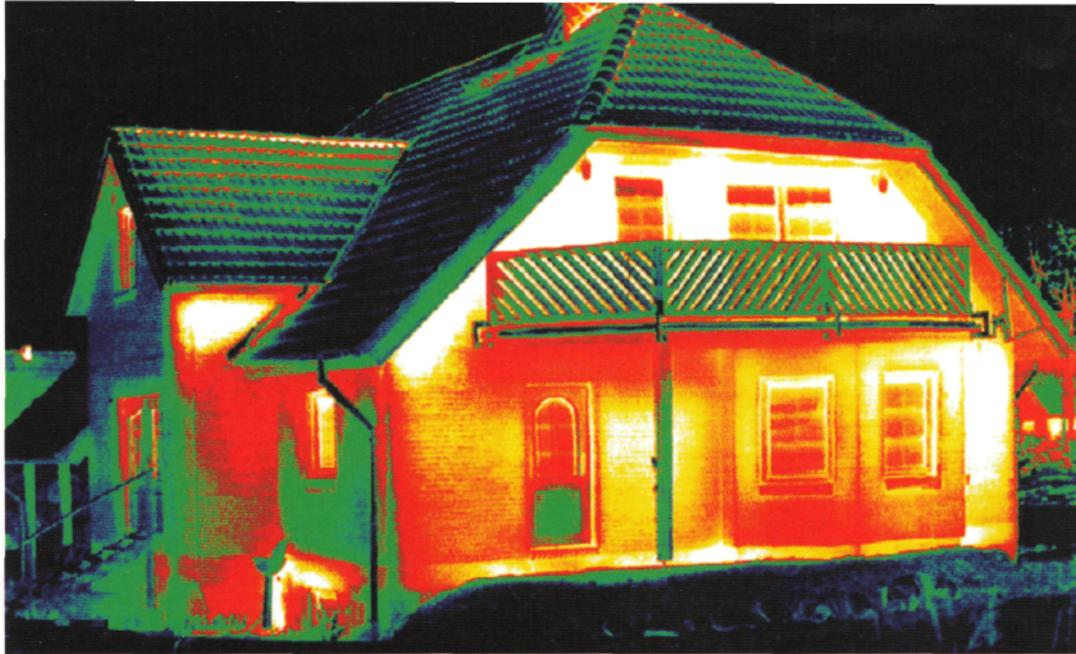
Die mit einer Infrarotkamera erstellte Thermografie belegt die Wärmeverluste des Einfamilienhauses. Die Farbe Blau zeigt: Das Dach des Hauses ist gut gedämmt. Die Farbe Rot signalisiert deutliche Wärmeverluste, denn die Fassade hat keine Dämmung.
