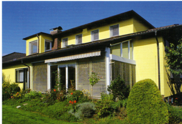
Wohnhaus in Buchkirchen, System LINEA citrusgelb
